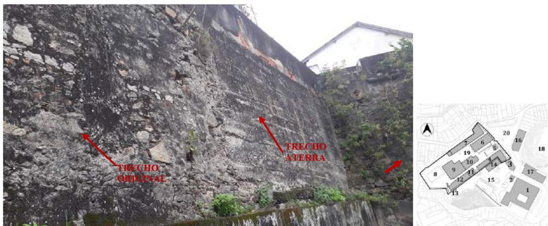
**Figura 68: Fotografia do trecho do perímetro aterrado, com indicação das diferentes técnicas construtivas do trecho original e do trecho aterrado. Fonte: COSTA/2017**
