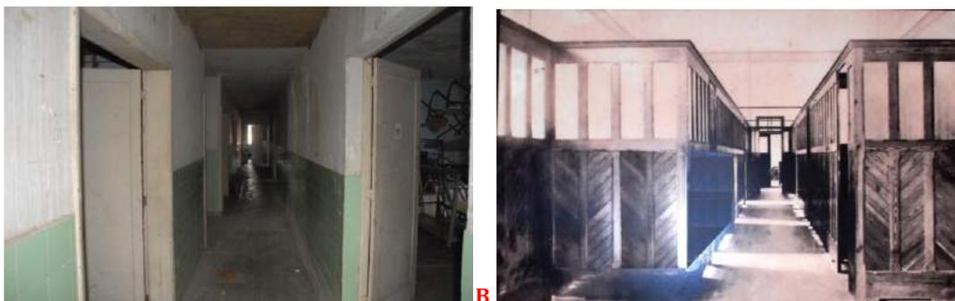
**Figura 211: Fotografia de 2010, com as subdivisões internas em alvenaria; e fotografia de c. 1920, com as subdivisões internas em madeira. Fonte: Leandro Campos/2010 e Acervo 5º CGEO**
