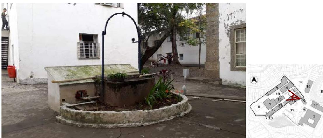
**Figura 102: Fotografia das alterações espúrias executadas na fonte da cisterna histórica, para atendimento das necessidades contemporâneas. Fonte: COSTA/2017**
