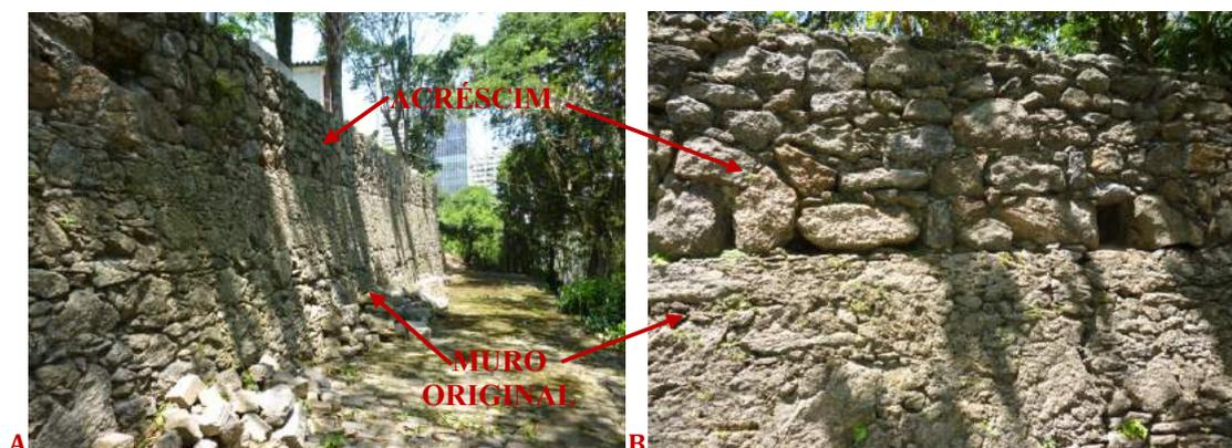
Figura 183: Fotografias do muro projetado por Massé, com indicação dos trechos original e de acréscimo; e a diferença entre as técnicas construtivas. Fonte: COSTA/2017
