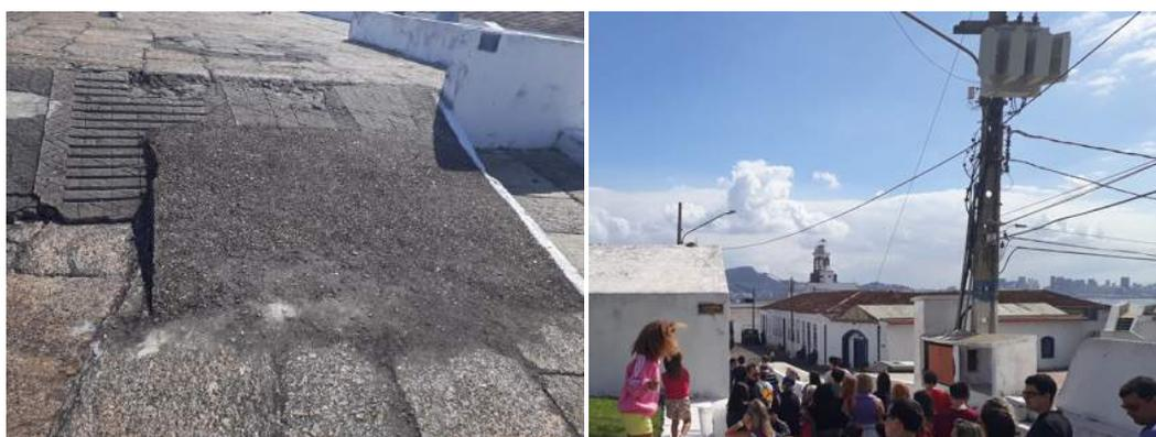
**Figura 123: Fotografias da rampa em concreto sobre piso em cantaria e da fiação exposta dos postes, na Fortaleza de Santa Cruz. Fonte: COSTA/2017**
